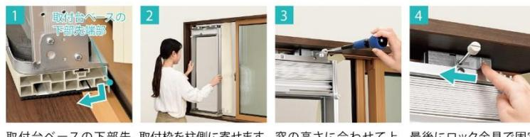
取付台ベースの下部先端部をサッシにかけます。取付枠を柱側に寄せます。窓の高さに合わせて上板を伸ばし、各所ねじナットをしっかりと締め付けます。最後にロック金具で固定します。
