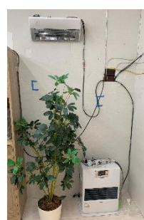
当社製品設置状況
